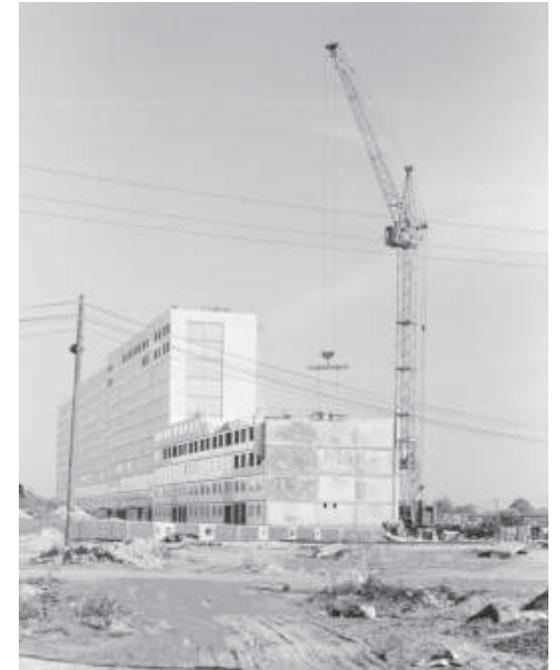
1972: Bauarbeiterunterkünfte im Innenhof, rechts oben: Bauzäune im Kiez, rechts: Montage der 10-geschossigen Plattenbauten mit Turmdrehkränen
