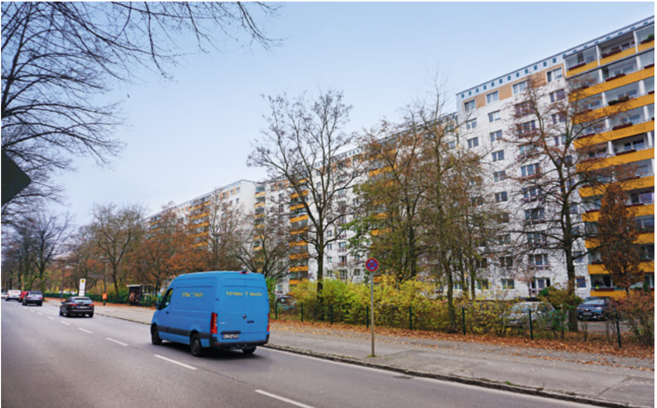
Straßenseite Bestand Salvador-Allende-Straße
